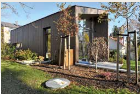
Unterirdisch eingelagerter Tank
